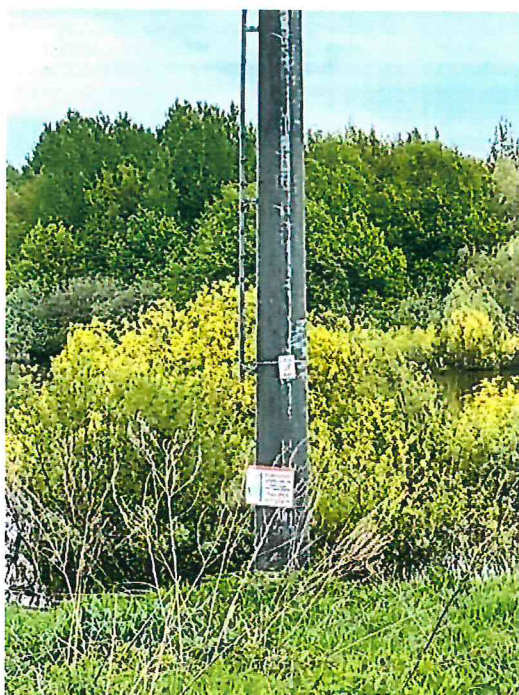
Знаки безопасности «Ловля рыбы смертельно опасна!» на опорах ВЛ на месте НС
