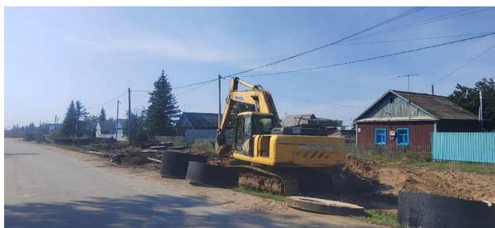
В настоящее время разбита ось трассы, подготовлены траншеи, уложено в две нити 9,4 км. полиэтиленовой трубы, установлено 28 колодцев. Работы продолжаются по ул. Тельмана р.п. Нововаршавка.
